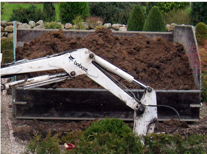
Gravning med gravkasse
