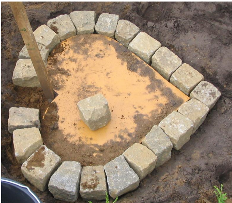
Brug af skabelon til sætning af hjerteformet stenkant.
