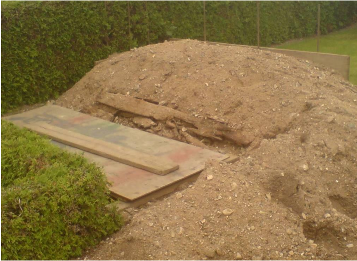
Gravning uden gravkasse
