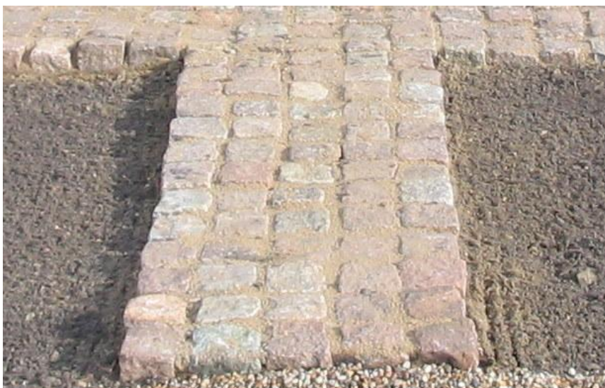
Brostensbelægning i færdig højde med plads til løs belægning
