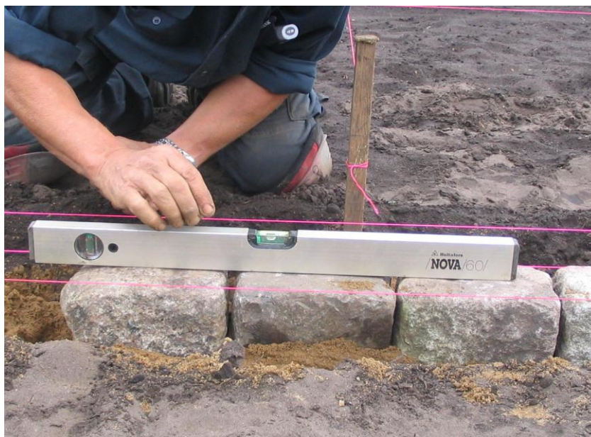
Stenkant af brosten med højdesnor og retningsnor.
